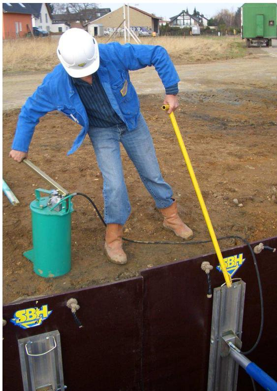
Zusammengeklappten Rahmen mittig zur Schalplatte PERI Fin Ply ausrichten, in den Graben ablassen und auseinander klappen.
