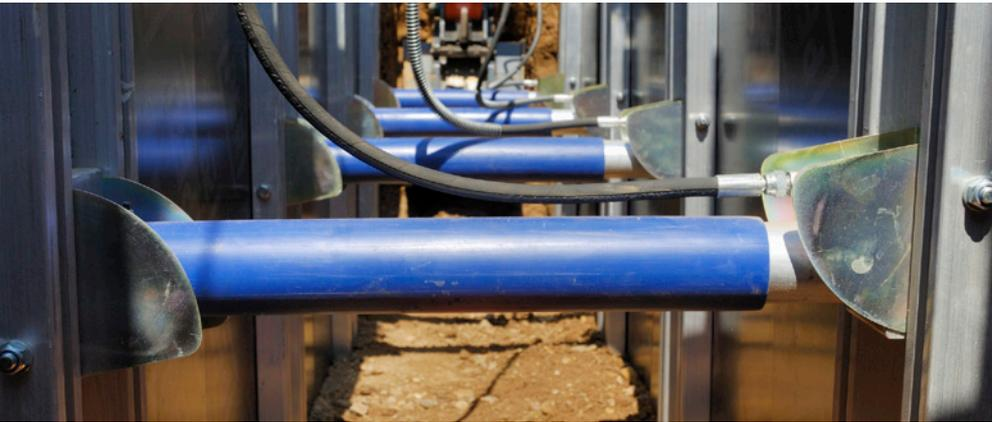
Der Schnellverbau 260er Serie eignet sich speziell für Verbautiefen bis 2,00 m.
